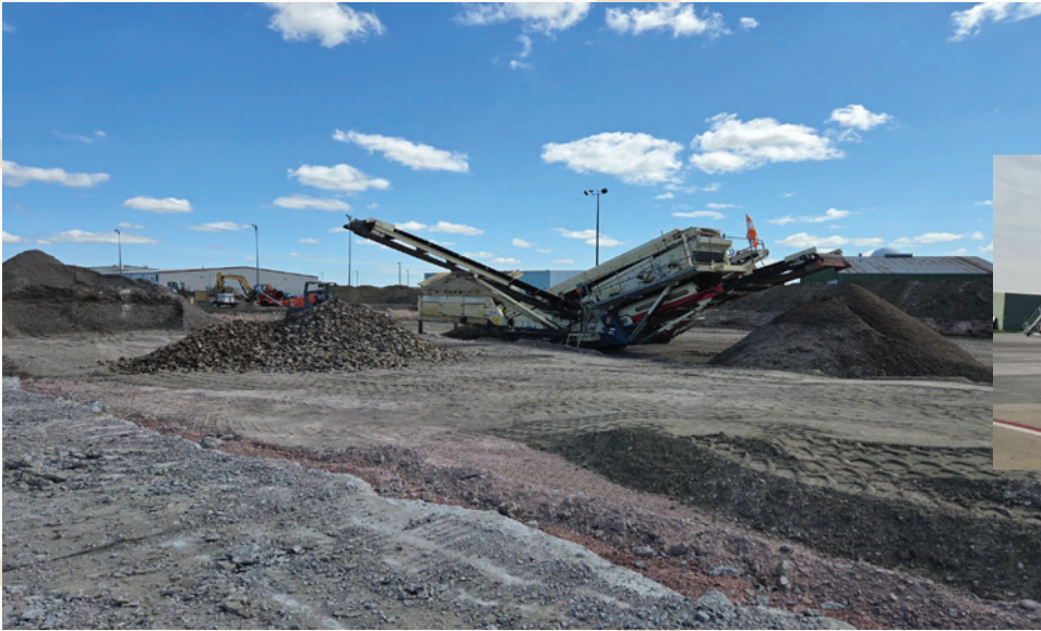
Cargo Apron Expansion
